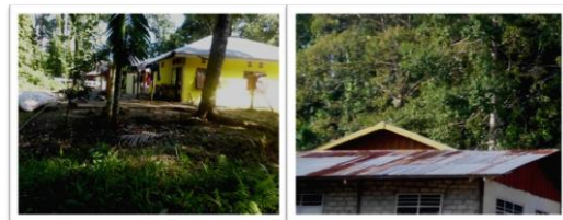
Gambar 11. Pembangunan Pemukiman di dalam TWA Gunung Meja
